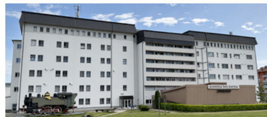
Stavba po prenovi
